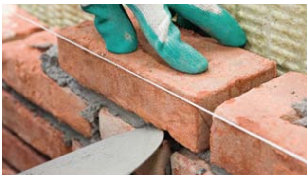
Na het invlijen de steen niet aankloppen
