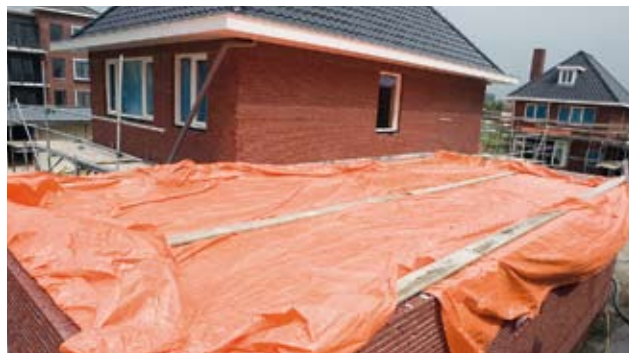
Vers metselwerk moet tegen regen worden beschermd
