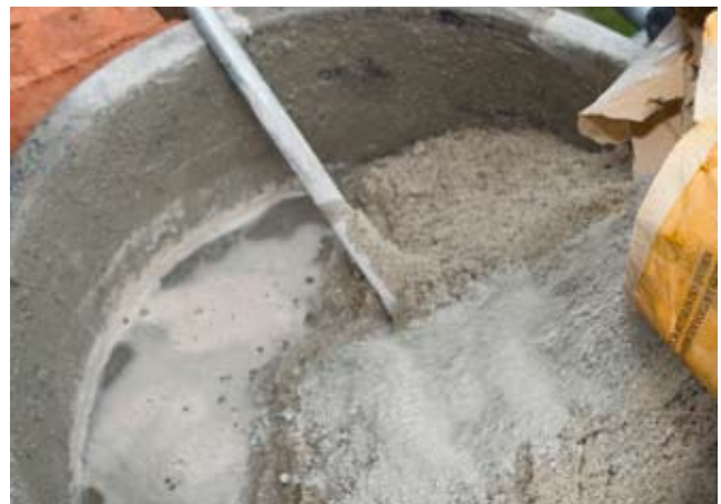
Aan Metselcement hoeft alleen leidingwater en metselzand te worden toegevoegd
